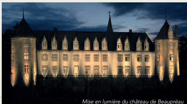
Mise en lumière du château de Beaupréau
