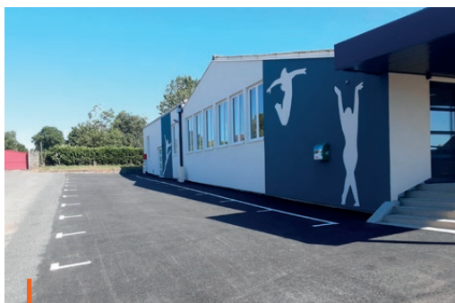
Parking du gymnase Chantreau avec une place PMR sur le côté de la salle.
