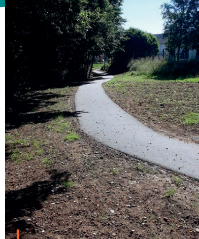
Chemin le long du Montatais qui reste inondable en période de crue.
