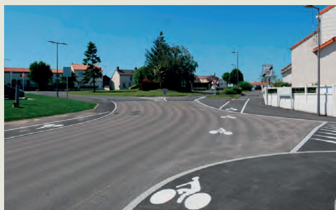
Zone du Bocage
