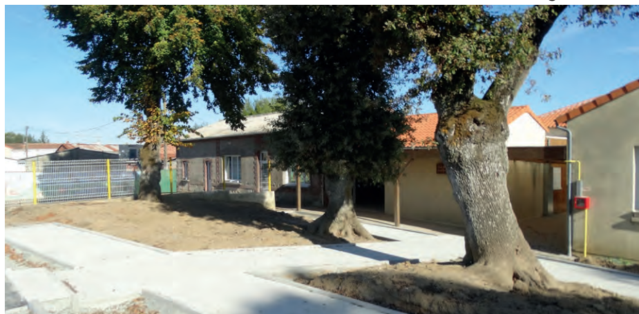
Au Pin-en-Mauges, les travaux engagés à l'école Joseph Girard faciliteront l'accès aux classes qui se trouvent à un niveau inférieur, en aménageant une pente douce et sécurisée.
